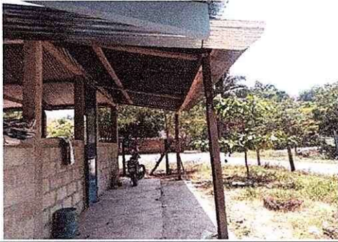
Foto 3: ampliación de aula de preprimaria
