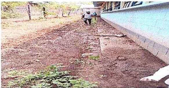
Foto 5: Reparación de canal de agua
